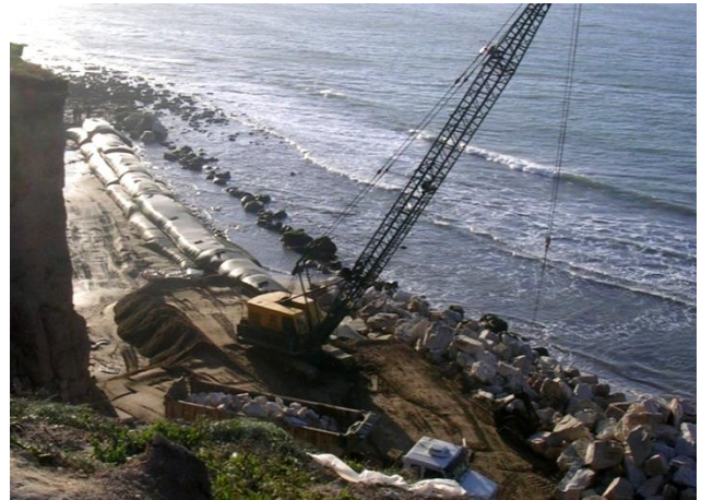
Figura 11. Vista de la protección al pie del acantilado
