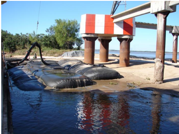
Figura 4. Llenado de geocontenedores
