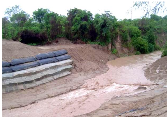
Figura 15. Obra finalizada en época de lluvias
