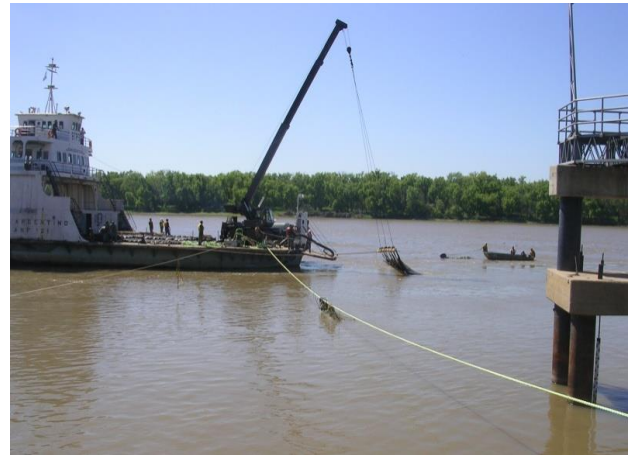
Figura 7. Colocación de manta base
