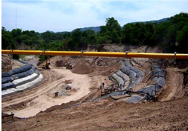
Figura 13. Vista general de la obra
