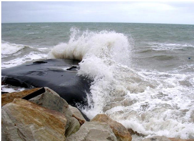
Figura 10. Avance del espigón de acceso
