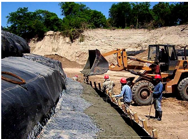
Figura 14. Recubrimiento de geocontenedores con H 9
