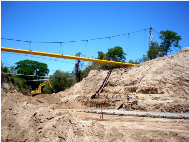
Figura 12. Barranca y cruce del gasoducto
